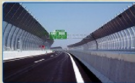
遮音壁（専用部）
